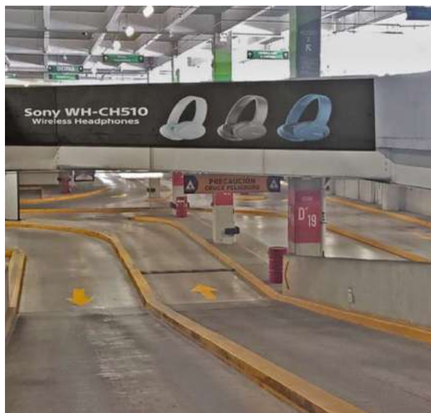
Cenefa de rampa en descenso de N-1 a sótano.
