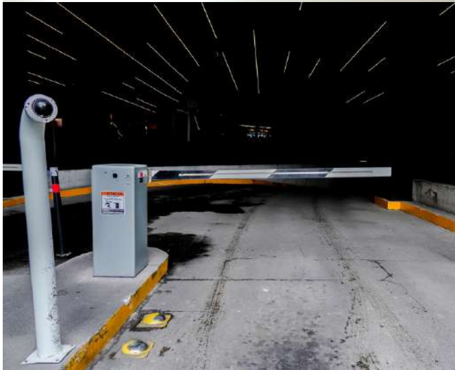
ENTRADA ACCESO OBRERO MUNDIAL
