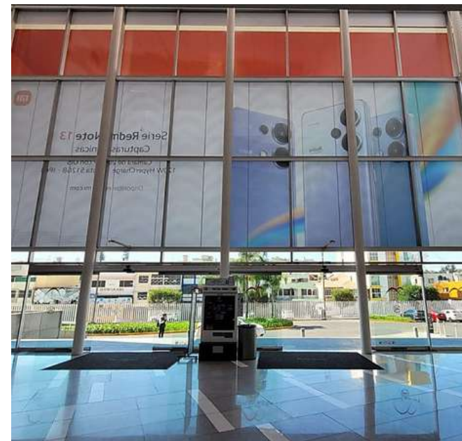
FACHADA INTERIOR (ACCESO 2) MC DONALD 'S Y/O CENTRAL
