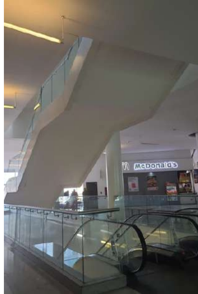
ESCALERA A UN COSTADO DE FOOD COURT (ACCESO 2) DE N2 A AZOTEA 1
