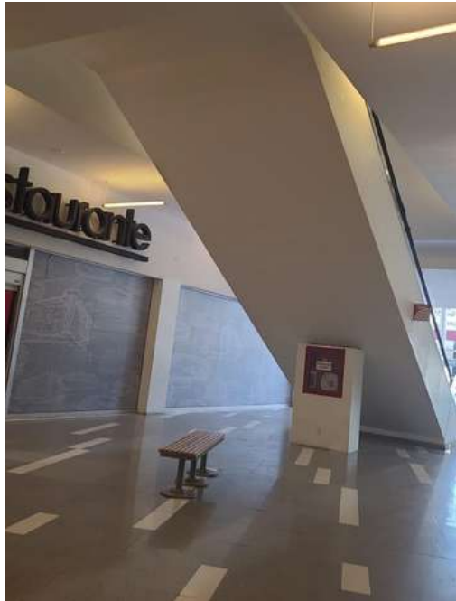
ESCALERA A UN COSTADO DE LIVERPOOL (ACCESO 1) DE PB A N1
