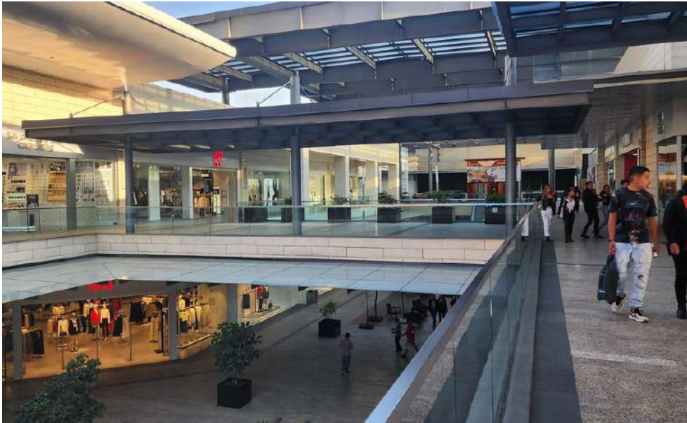
N2 PUENTE CONECTOR ENTRE CASA DE LAS CARCASAS & SANTA CLARA
