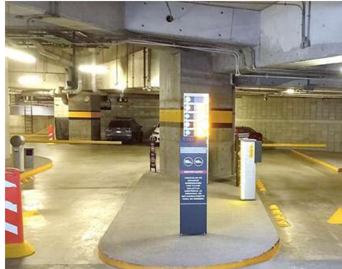
ENTRADA RÍO SAN JOAQUÍN A TORRE DE OFICINAS
