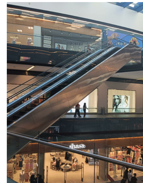
ESCALERAS ELÉCTRICAS: N1 ENTRE SFERA Y H&M A N2 SUBURBIA
