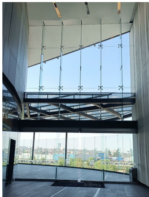
MUROS: PB – ACCESO TERRAZA ZONA BANCOMER
