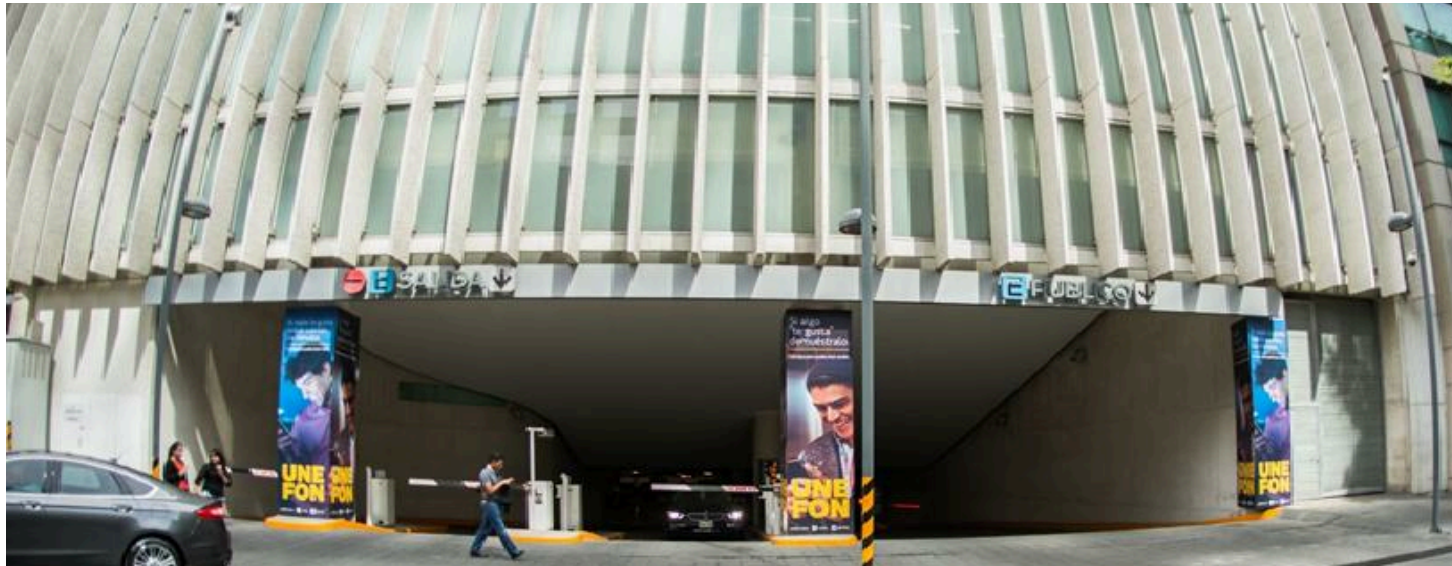
ESTACIONAMIENTO ACCESO NÁPOLES
