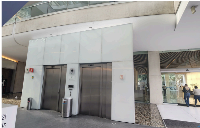
PB A UN COSTADO DE ACCESO A OFICINA
